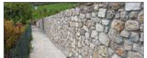
Le mur maintenant rénové.
